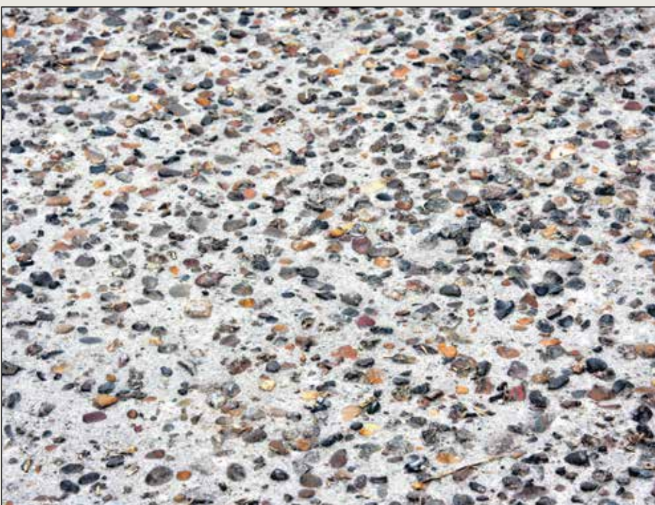
Betonbunden på billedet til venstre er hårdt skadet af ensilagens lave pH, og betonen er smuldret væk, så småsten ligger løse. På billedet til højre ses en asfaltbund, som ikke er påvirket af ensilagen.
