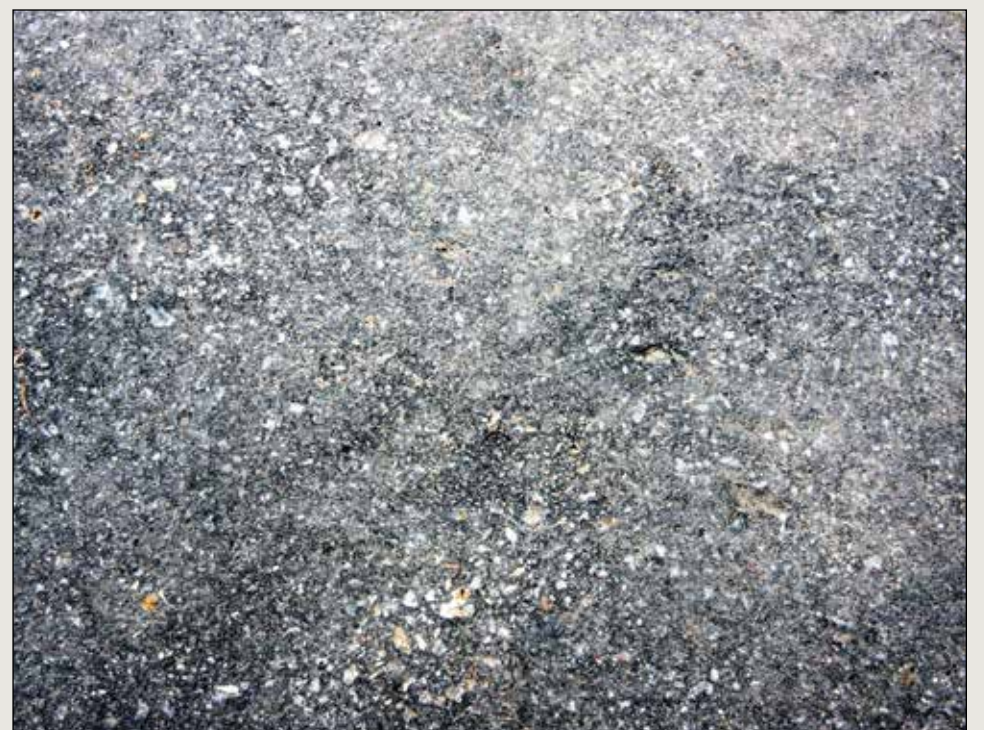
Betonbunden på billedet til venstre er hårdt skadet af ensilagens lave pH, og betonen er smuldret væk, så småsten ligger løse. På billedet til højre ses en asfaltbund, som ikke er påvirket af ensilagen.
