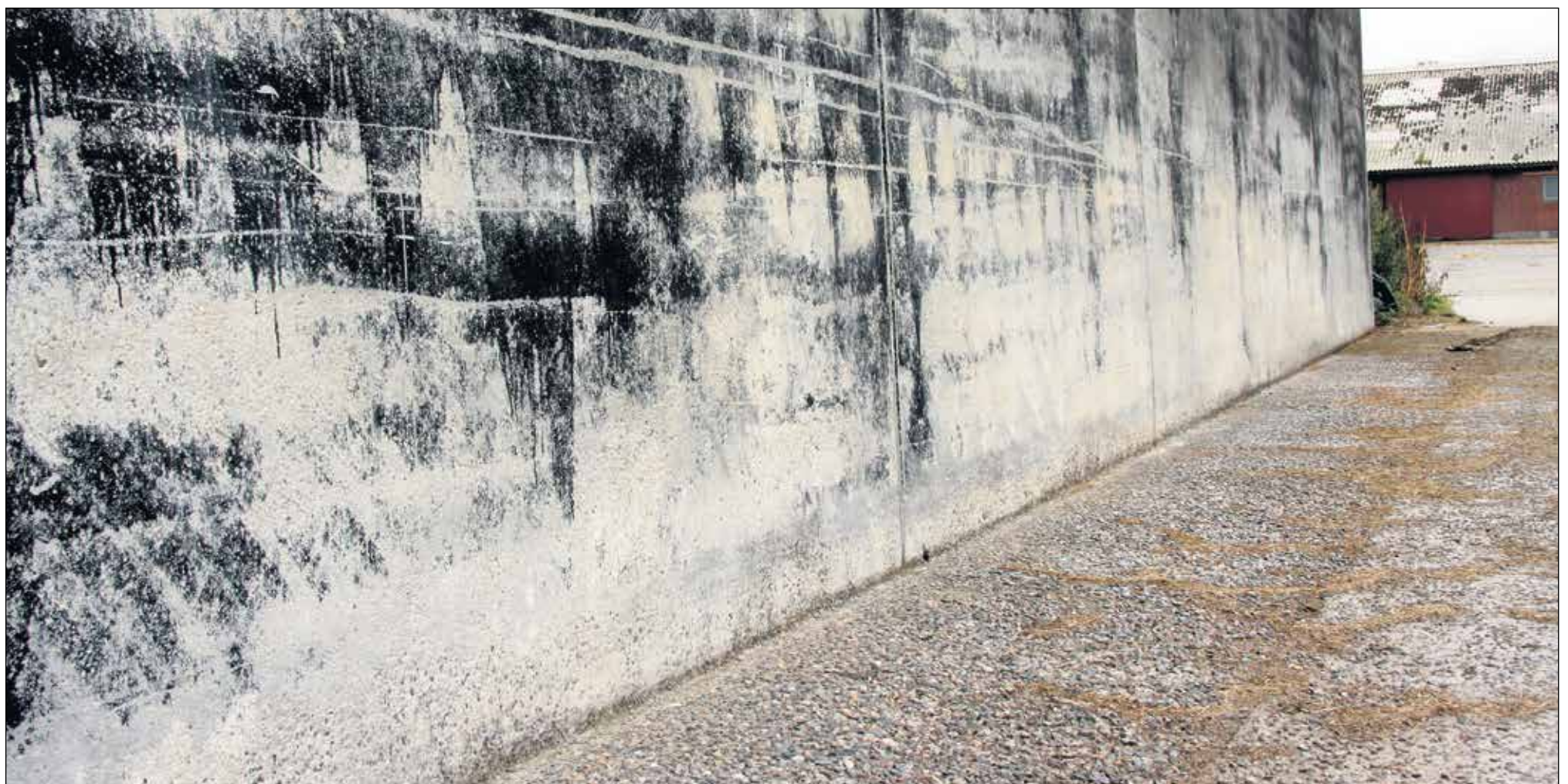
Ikke bare silobunden er tæret, men også den nederste del af L-elementet. Både fra L-elementet og fra bunden løsnes småsten hele tiden.
